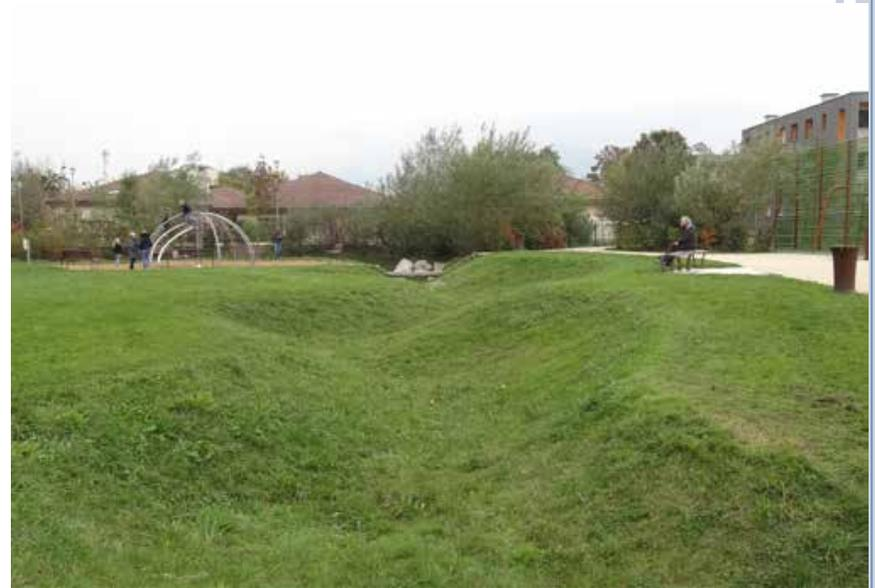
Seyssins - Bassin de récupération et d'infiltration des eaux pluviales au sein d'un parc
