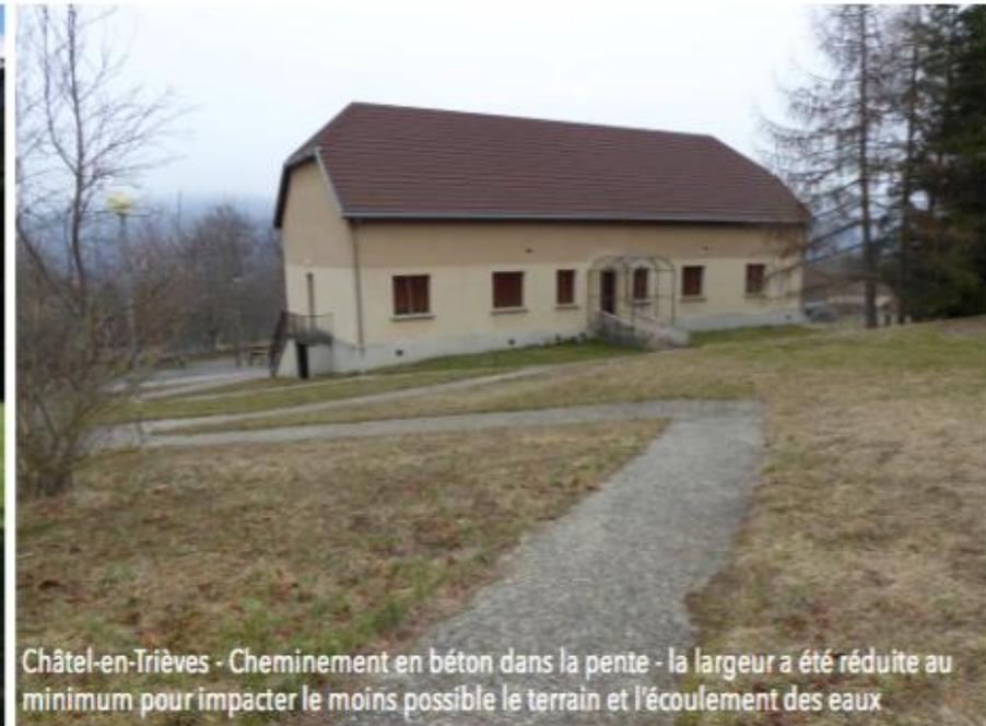
Châtel-en-Trièves - Cheminement en béton dans la pente - la largeur a été réduite au minimum pour impacter le moins possible le terrain et l'écoulement des eaux
