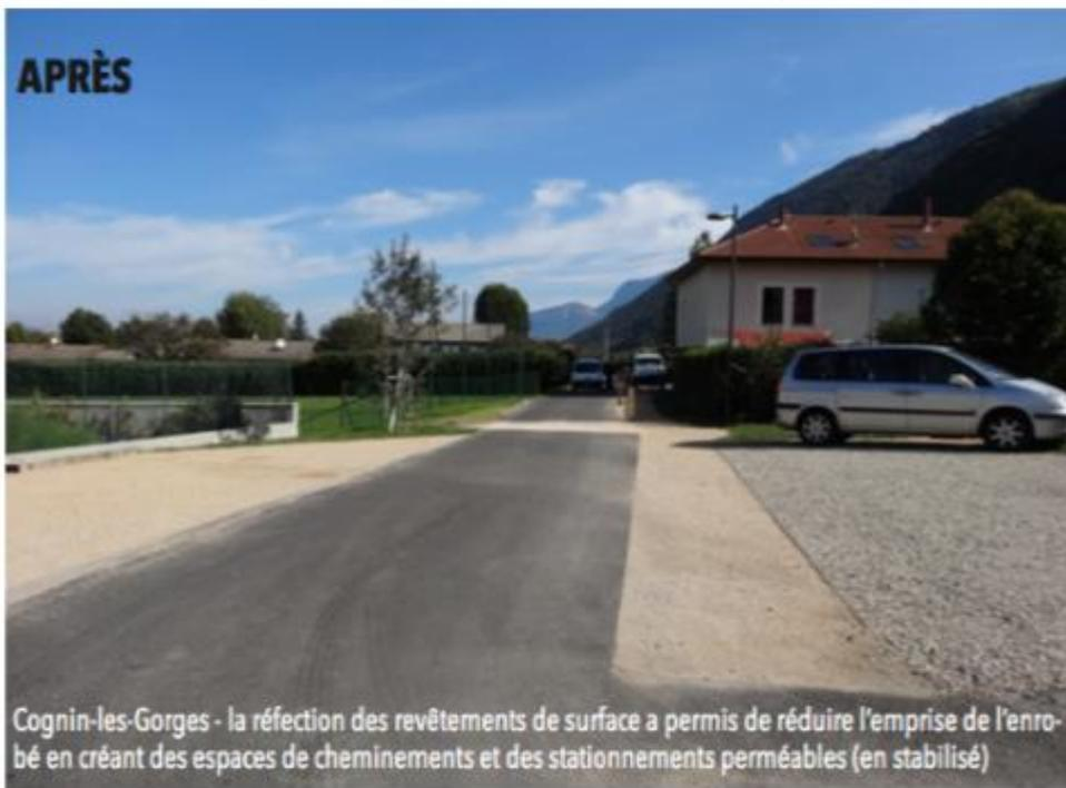
Cognin-les-Gorges - la réfection des revêtements de surface a permis de réduire l'emprise de l'enrobé en créant des espaces de cheminements et des stationnements perméables (en stabilisé)
