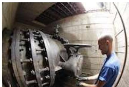
Figure 110 : manoeuvre de vannes
