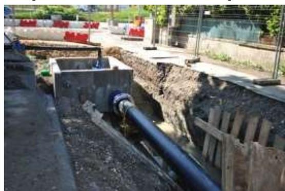
Figure 60 : renouvellement de la conduite D400 de La Tronche
