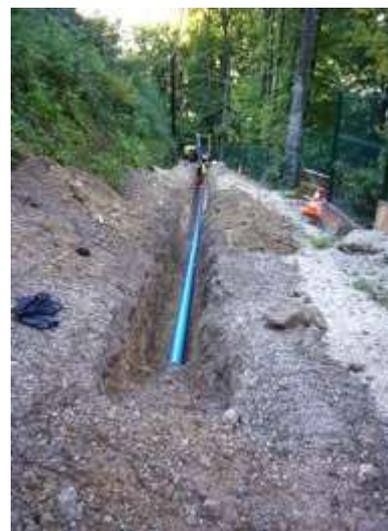
Figure 135 : nouveau refoulement à Quaix-en-Chartreuse
