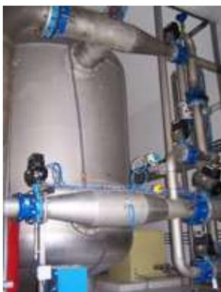
Figure 38 : station de traitement de la turbidité, source de Jonier
