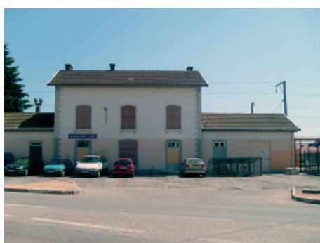
Parking de gare
