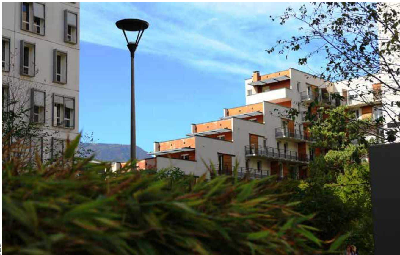
Immeuble d'habitat à Europole
