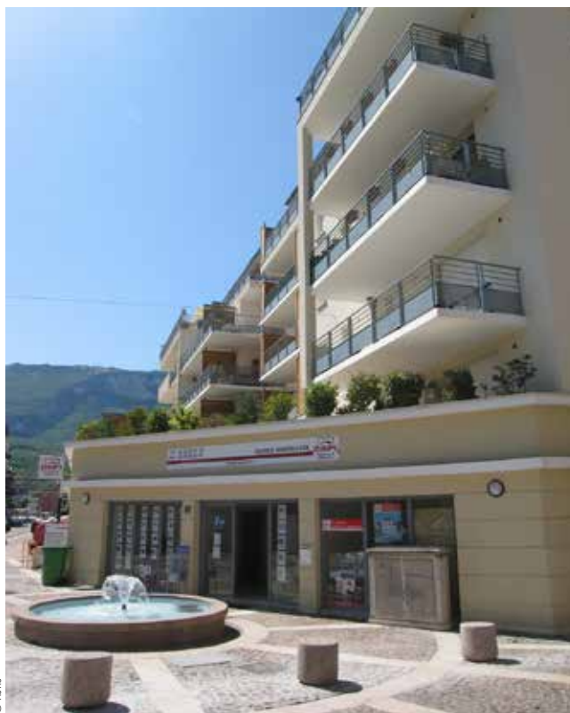
Renouvellement urbain. Fontaine
