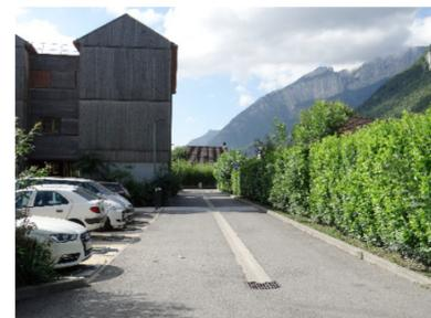
Complémentarité d'un parking perméable et d'un avaloir pour la gestion pluviale - Veurey-Voroize
