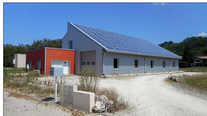
Locaux d'activité avec panneaux photovoltaïques dans la Z.A. de Clairivaux, Saint-Marcellin Vercors Isère. Crédits : Vincent Escartin / AURG.
